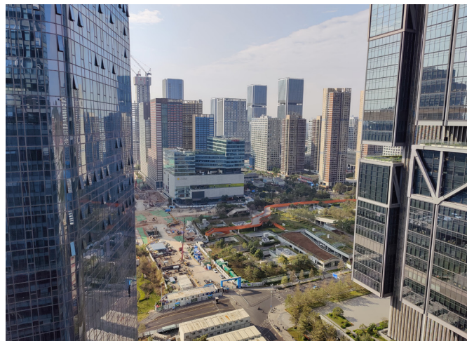
Immeubles en construction dans la périphérie de Shenzhen.
